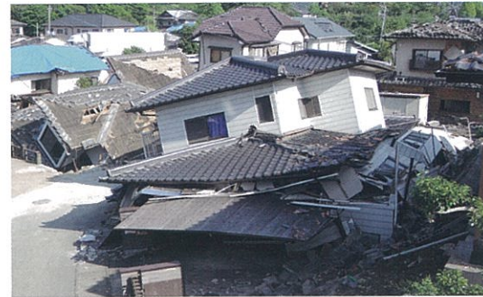
地震による被害例（熊本地震）
